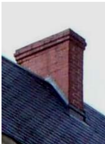
Exemples de petites souches à l'aplomb des murs de refends. A gauche, profil d'origine restitué, à droite profil du XIXe siècle.
