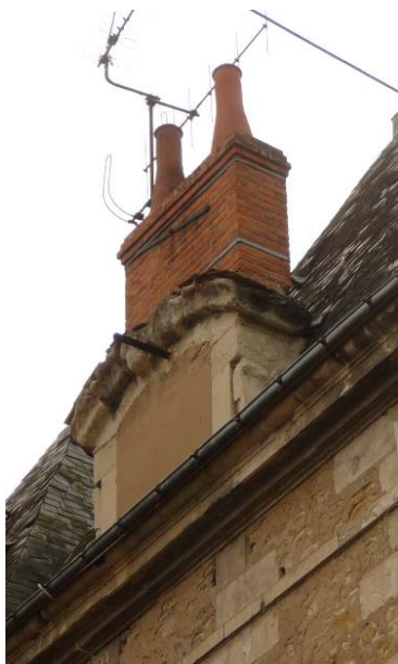
Exemple d'une souche ajoutée à l'aplomb d'une lucarne et ayant entraîné l'occultation de celle-ci.
