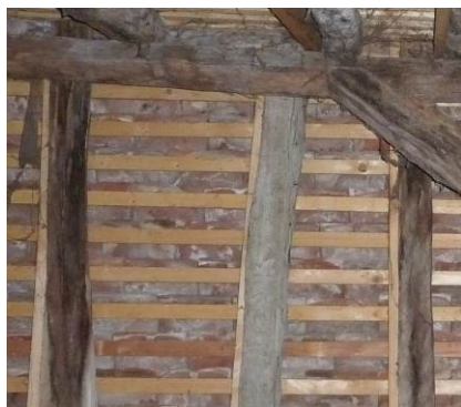
Exemple de pose sur liteaux
