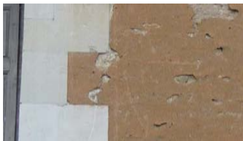
L'enduit traditionnel (ici légèrement altéré) utilisé à partir du XVIIe siècle
