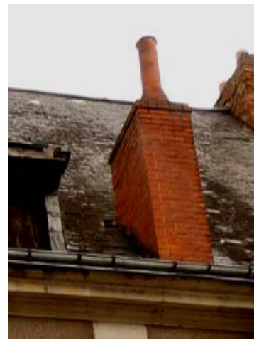
Exemple de souche ajoutée à l'aplomb du mur de façade à côté d'une lucarne.
