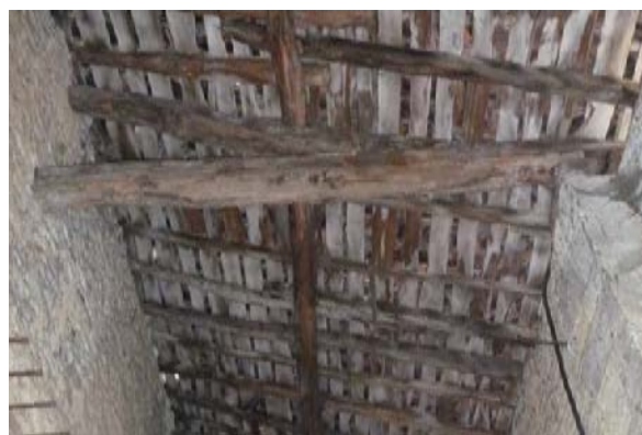
Exemples charpente de couverture composée de demi-ferme, panne intermédiaire, chevron et volige non jointive.
