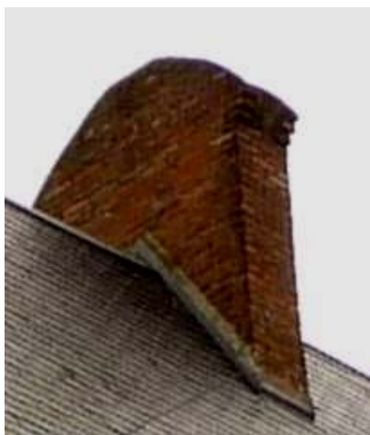
Exemples de petites souches à l'aplomb des murs de refends. A gauche, profil d'origine restitué, à droite profil du XIXe siècle.
