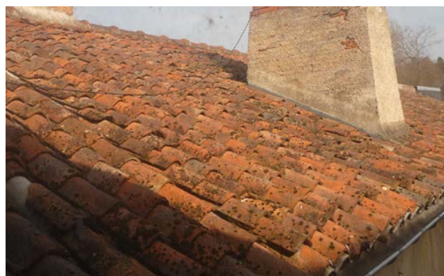
Exemples de tuiles « tige de botte » : ici posées en recouvrement sur des plaques de fibrociment.
