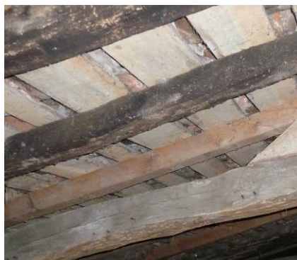
Exemple de pose sur voliaes non jointives
