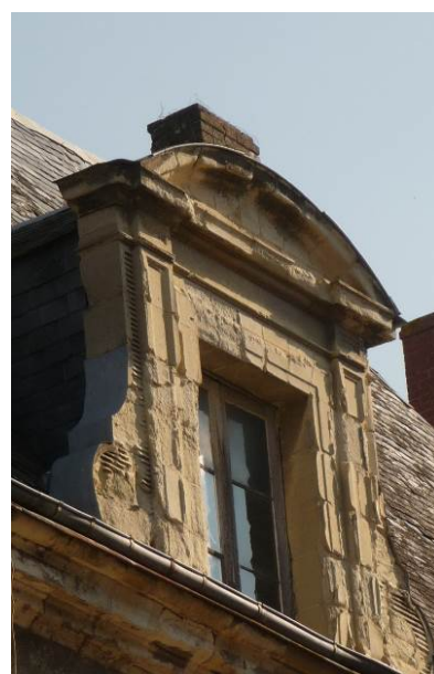
Exemple d'une souche ajoutée à l'arrière du fronton d'une lucarne afin de la dissimuler. Le conduit dévoyé dans les combles a permis de conserver l'ouverture de la lucarne.
