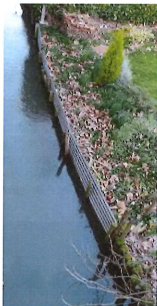
Maintien des berges par les tôles ondulées
