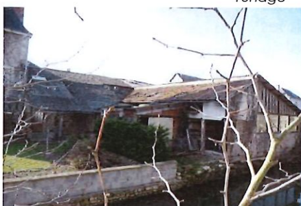
Berge maçonnée surmontée d'un muret en parpaing
