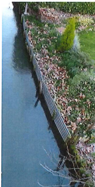
Maintien des berges par les tôles ondulées
